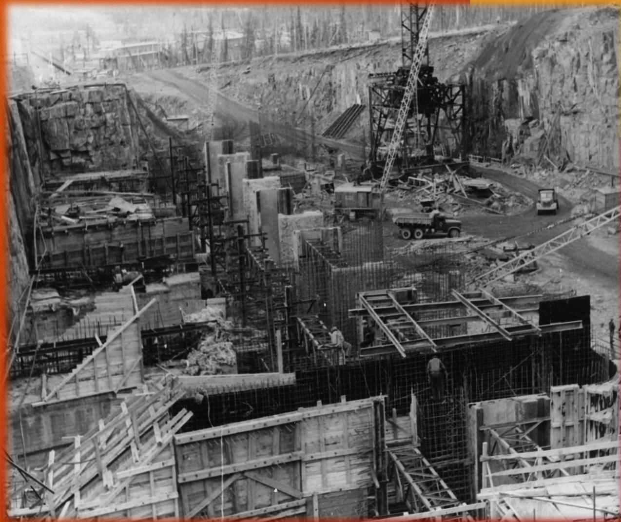
МКУ НГА. Ф.Р-75. Оп.1. Д.4. Сооружение водоприемника Усть-Хантайской гидроэлектростанции
